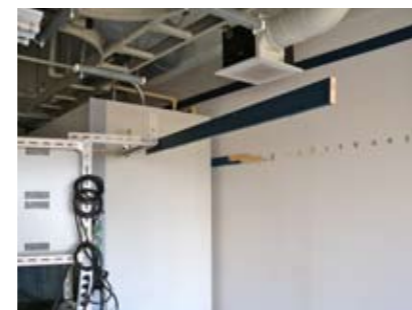
壁からはがれた、棚を固定するための画枠。
