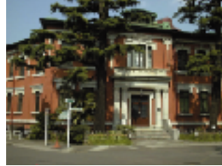
医学部附属病院側から見た東館
